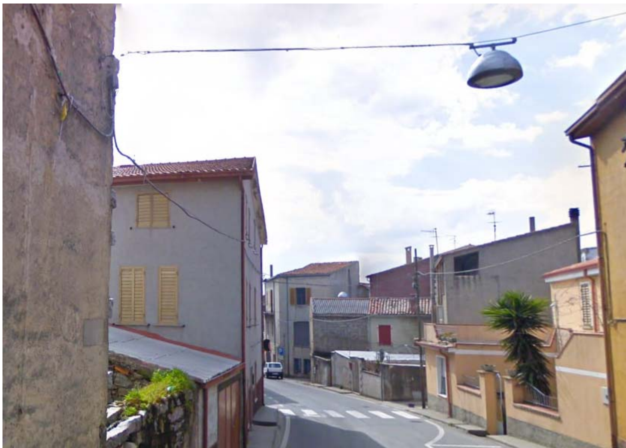
Vista linea aerea esistente del tratto Via Roma – Via Cagliari
